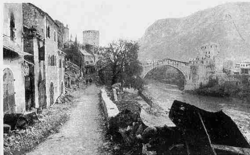
Il ponte di Mostar già visibilmente danneggiato prima che le bombe croate lo facessero crollare
